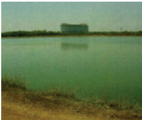
รูปที่ 1 บ่อบำบัดน้ำเสียของเทศบาลนครนครราชสีมา เป็นระบบบำบัดน้ำเสียแบบบ่อบำบัด (Oxidation Pond)
