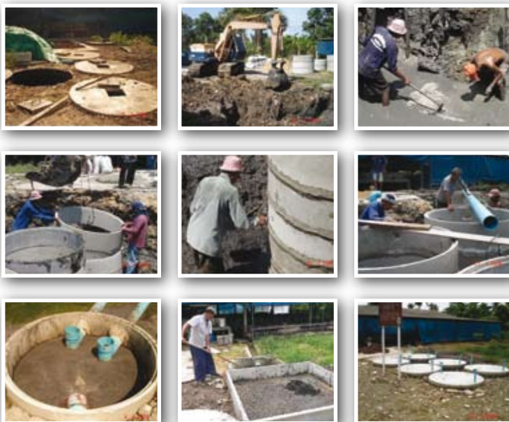
ภาพที่ 3 ขั้นตอนการปรับปรุงและดูแลระบบถังกรองไร้อากาศ
