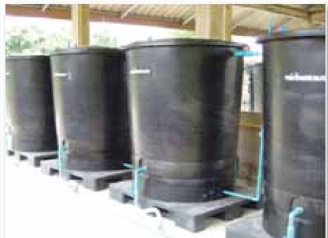
ภาพที่ 4 แสดงถังหมักแบบ SEBAC ติดตั้งที่โรงงานปุ๋ยชีวภาพในหมู่ที่ 2 ตำบลสองพี่น้อง อำเภอนาโพธิ์ จังหวัดจันทบุรี
