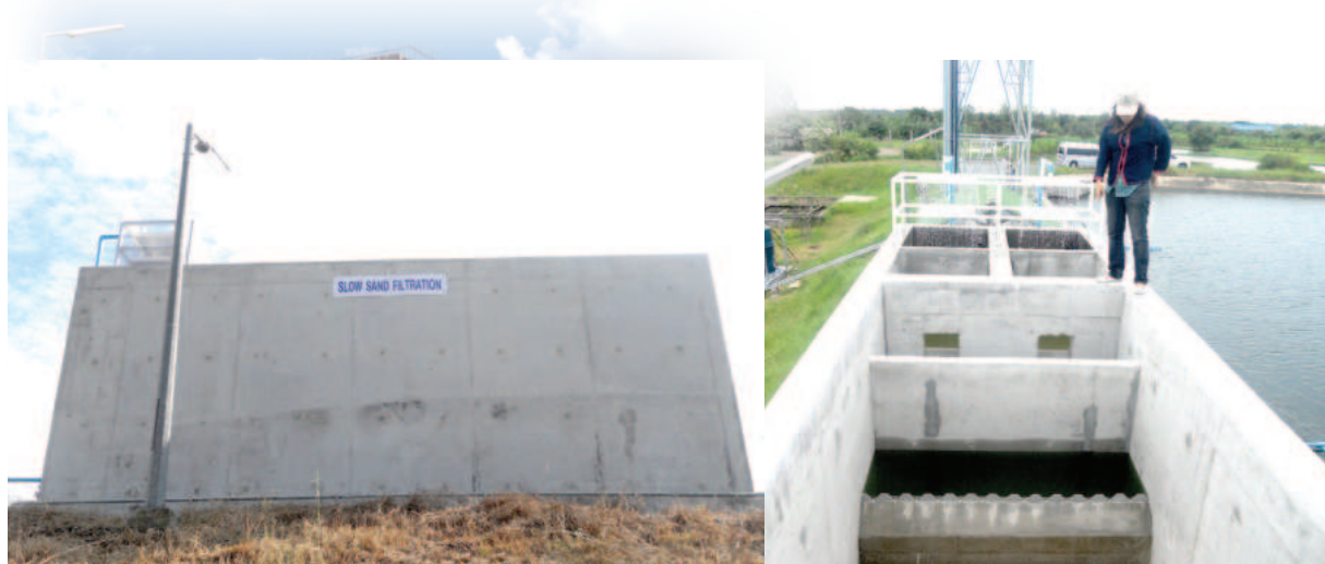
รูปที่ 5 แสดงการติดตั้งและทดสอบเดินระบบทรายกรองช้า (Slow sand filtration)
