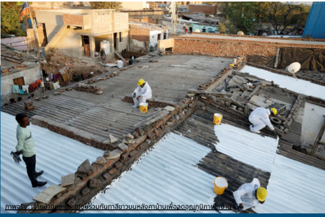
ภาพจริง: ประชาชนร่วมกันทาสีขาวบนหลังคาบ้านเพื่อลดอุณหภูมิภายในบ้าน
